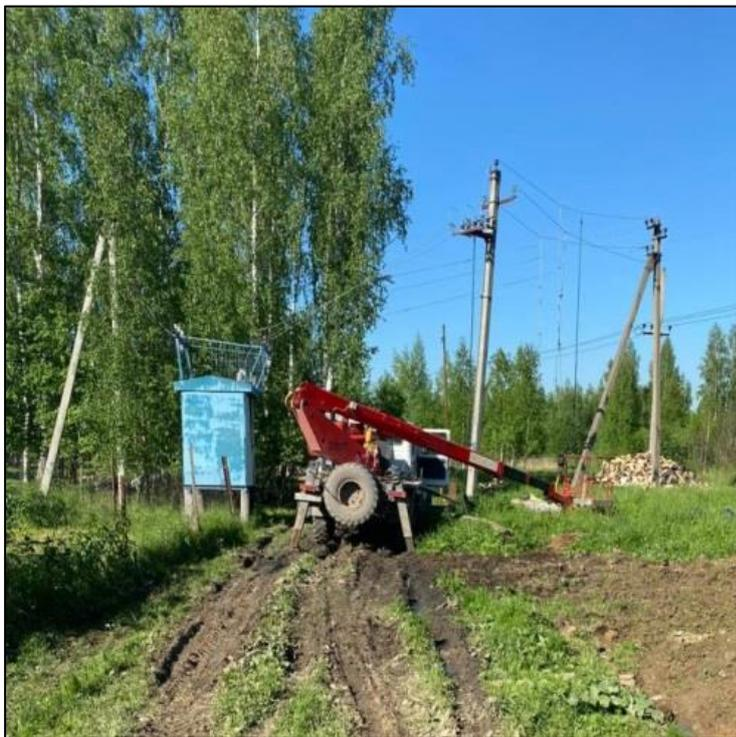
В 12:59 по прибытии на ТП № 534 оперативно-выездная бригада 1 (далее – ОВБ 1) по команде диспетчера приступила к осмотру оборудования и проведению замеров нагрузки и напряжения в РУ-0,4 кВ. По результатам проделанной работы ОВБ 1 выявлен перекос напряжения и обнаружены 2 повреждённых проходных изолятора и обгоревший шлейф
